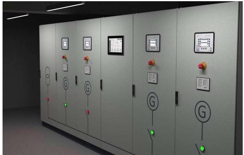
El easYview viene preparado con dos modos de aplicación básicos: un modo HMI remoto y un modo mini-SCADA.
